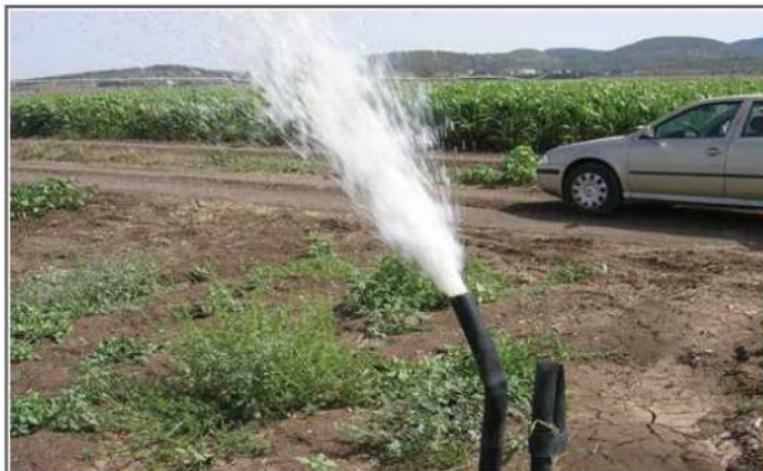
Rinçage manuel du réseau goutte à goutte
